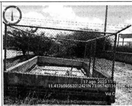
**FOTO 32.** Trampa de lodos al lado de PTAR. Pozo profundo que resume las aguas residuales las cuales se bombean a la planta compacta donde se hace la separación de sólidos.
